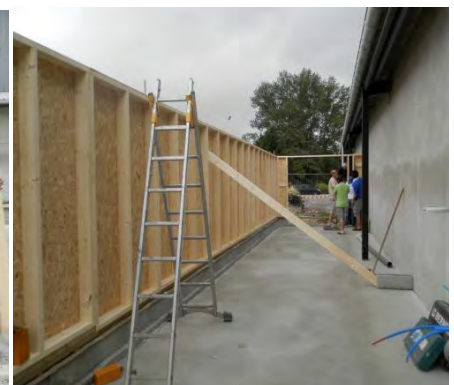
un premier mur est monté !
