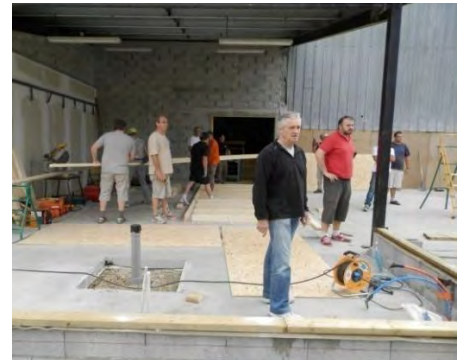
puis on construit les soubassements
