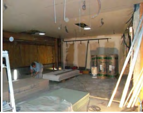
... enfin presque (déjà 3 mois de travaux !)
