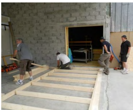
on fabrique les murs
